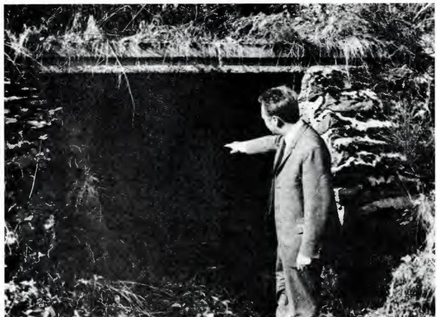
Herr P. Heinen führte uns in den Entwässerungsschacht am Ausgang des Dorfes, der 400 Meter tief in den Berg hineindringt und das Grundwasserproblem lösen sollte.
