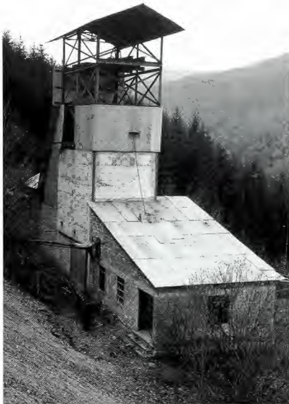
Der Förderturm und die Hebeeinrichtung sind, an der Erdoberfläche jedenfalls, sehr gut erhalten. Sie könnten die Arbeit bald wieder aufnehmen.
