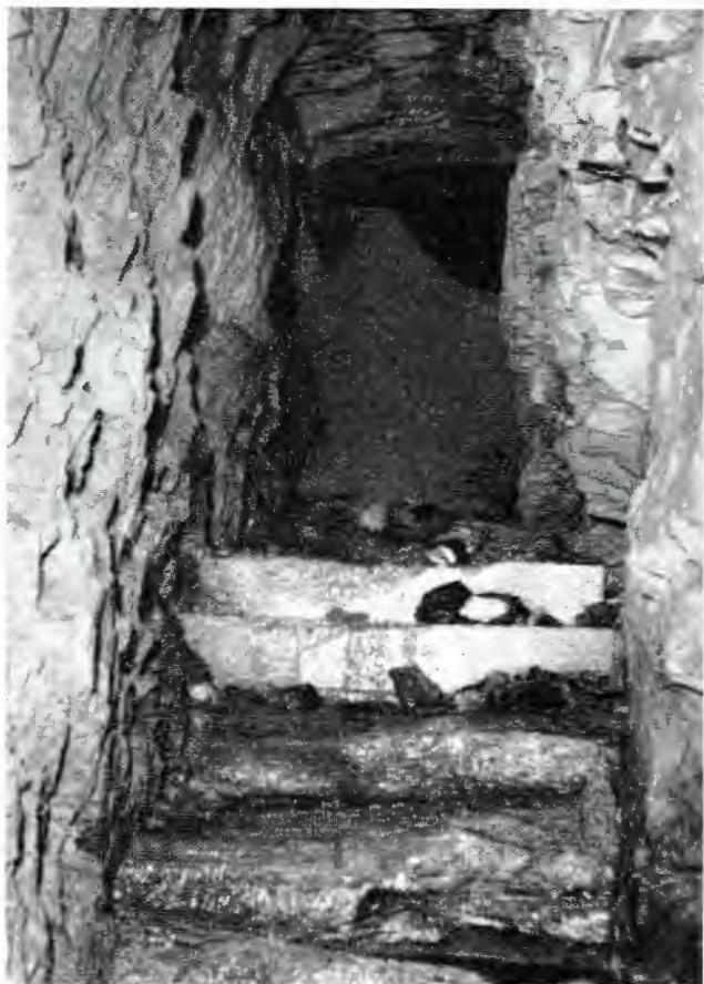
Der verschüttete Tunnelleingang, durch den man nur noch bis zum Luftschacht gelangen kann.
