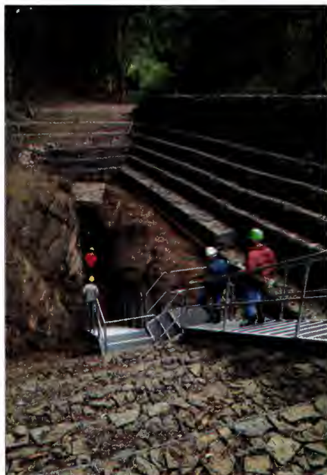
Beginn der Besichtigung: Einstieg in den Wasserstollen.
