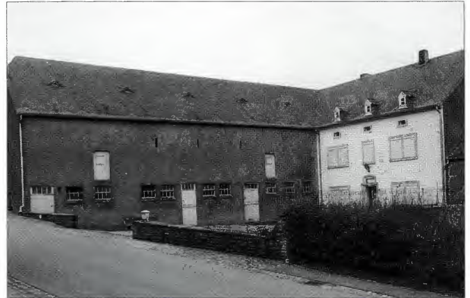
Neubau «a Schneidesch».
