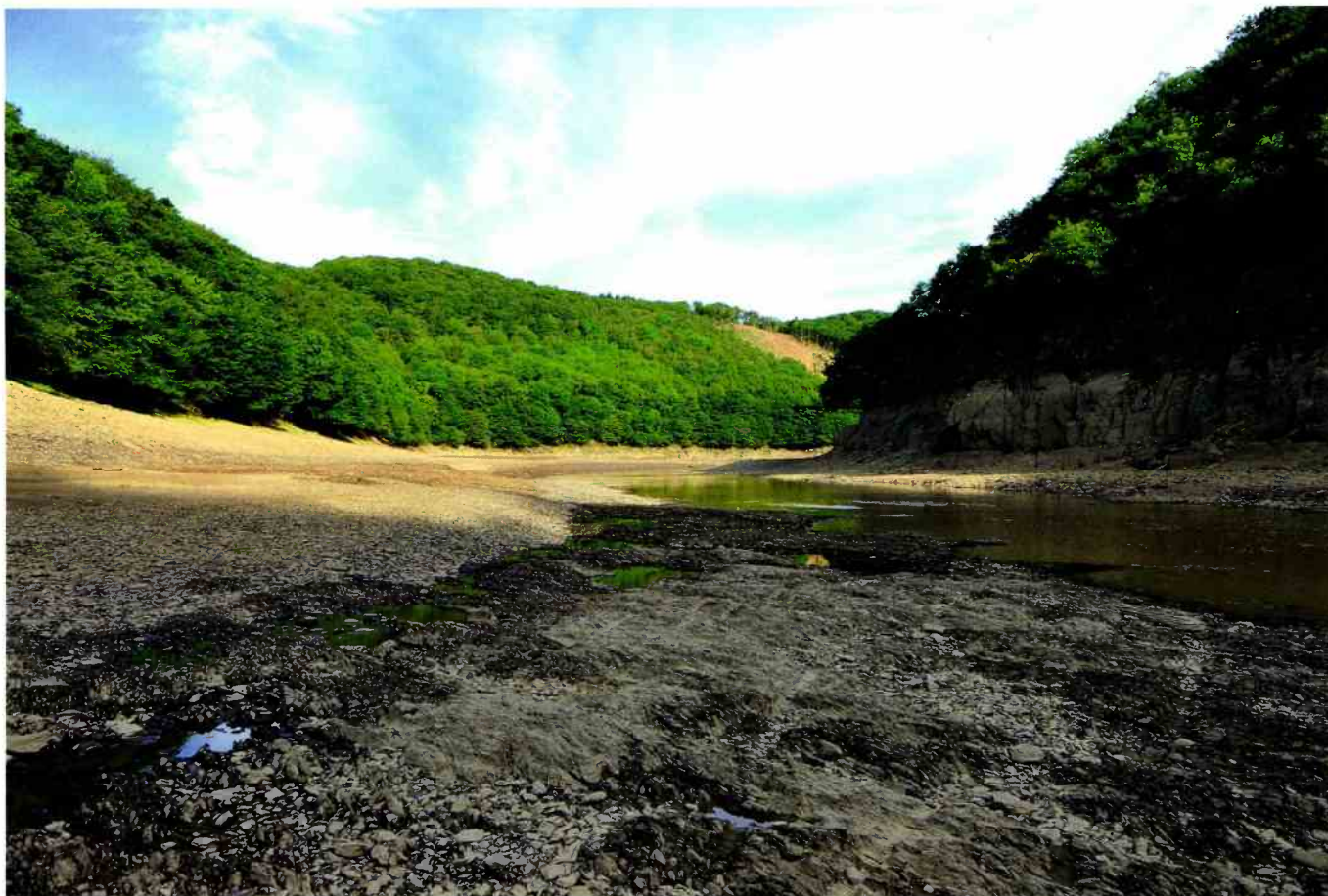
Das Ourtal bei der Entleerung zum Bau der 11. Maschine
