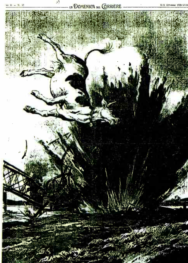
La mucca e la mina. In un paese del Lussemburgo, presso il confine tedesco, una mucca che pascolava ha calpestato i fili di una linea posta sotto un ponte ferroviario. Si è stabilito un corto circuito e, con una tremenda esplosione, il ponte è saltato. Anche l'incoscienza bestia, per lo spostamento d'aria prodotto dallo scoppio, è stata lanciata lontano. (Illustrazione di A. Brette)
