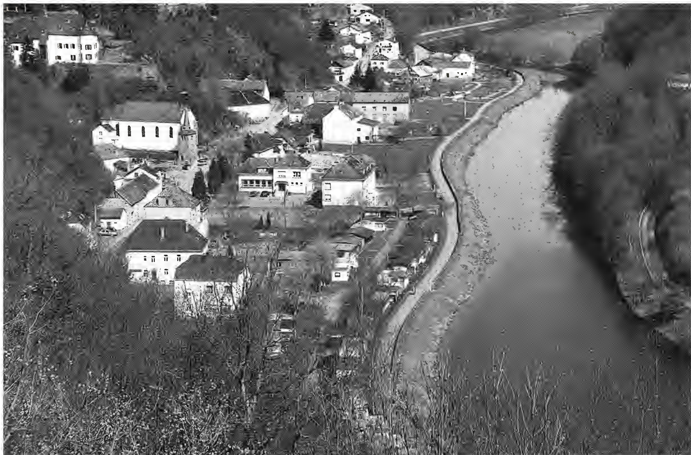
Our oberhalb der Wehrklappen.
